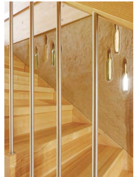
Das Abendlicht beleuchtet durch die eingeputzten Gläser die Treppe
